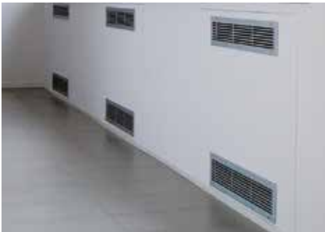
Instalación de pared
