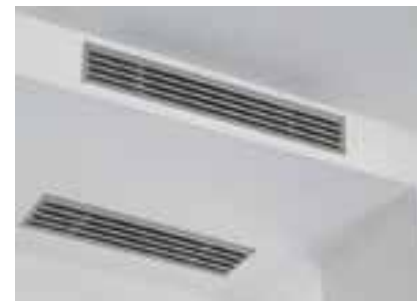
Instalación de techo
